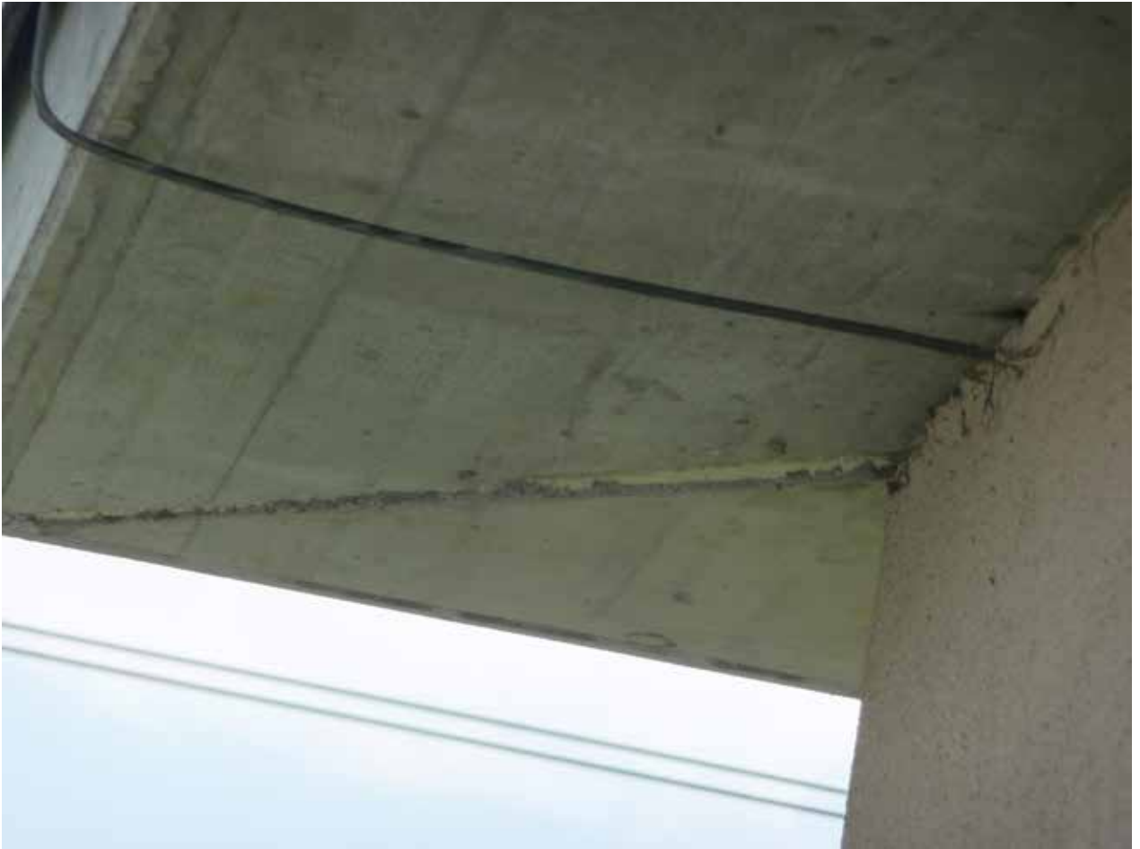
DG offene Fuge Dachuntersicht
