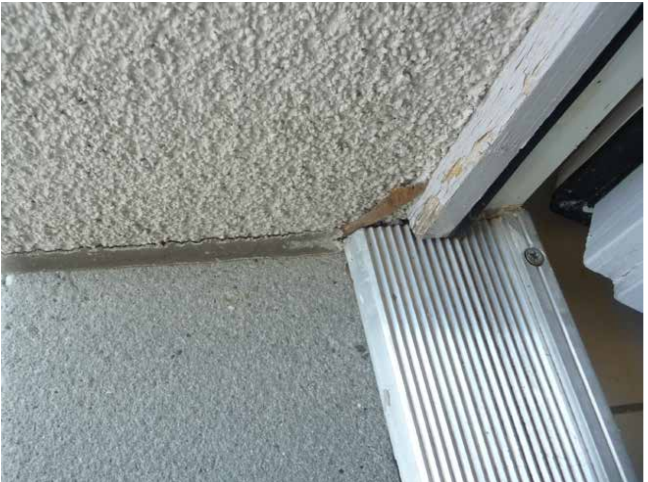
offene Fugen bei Türleibung
