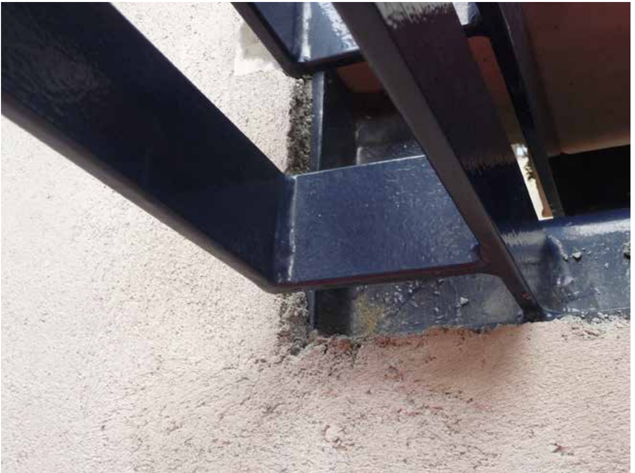
überhöhter Anschluss Überzug an Geländer Treppenhaus
