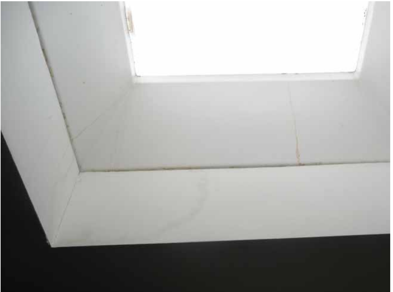
undichtes Oblicht
