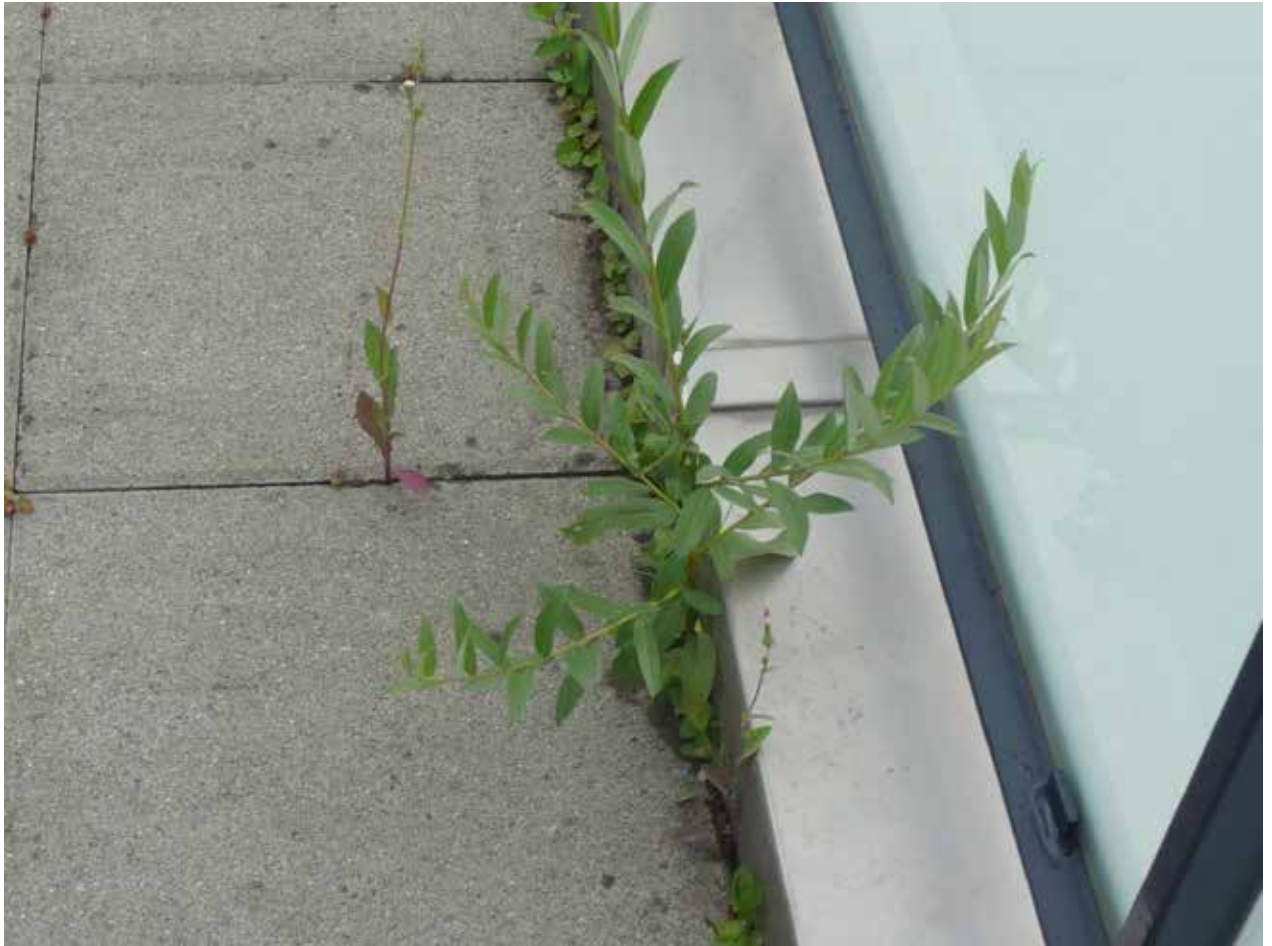
DG Bewuchs Terrasse
